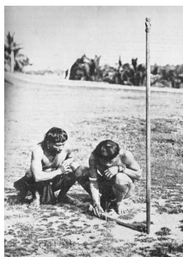
Slika 3.1 Gnomon - navpična palica, ki meče senco na vodoravna tla. Ko je senca najkrajša, je poldan. Takrat kaže senca smer sever-jug. Gnomon je najstarejši človekov merilnik. Prej ali slej ga neodvisno iznajdejo vsa ljudstva. Tukaj merita dva domačina na Borneu. (Needham, 1995)
